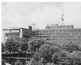
写2-1 三重県庁本庁舎(本庁舎)
