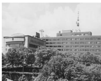
写1-1 三重県庁本庁舎(本庁舎)
