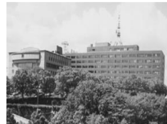
写真 1 三重県庁本庁舎 (本庁舎)
